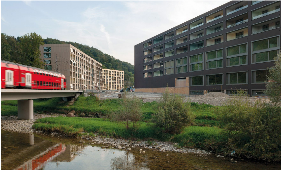
Abbildung 24: Sihlbogen-Quartier in Zürich-Leimbach. Quelle: BG Zur Linden
