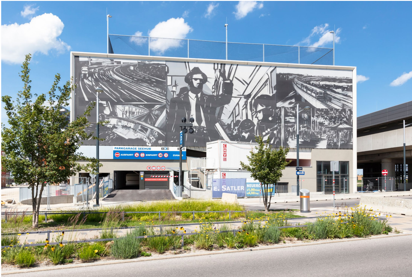
Abbildung 13: Sammelgarage in der Seestadt Aspern (Wien). Quelle: © Daniel Hawelka
