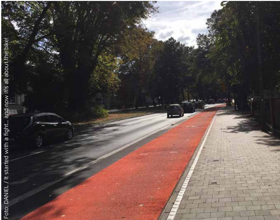
Abbildung 2: Die Umwandlung von Parkplätzen ermöglichte einen hochwertigen Radweg in Osnabrück.
